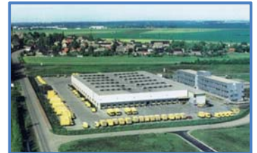
1999 BSZ 06 Halle in Hohenthurm
